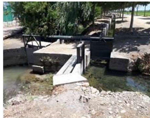
Foto 3. Canal Dren Borghino.
