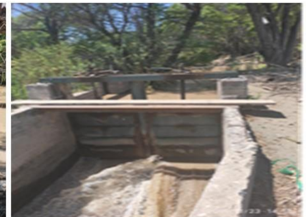
Foto 4. Canal Comunidad Panquehue.
